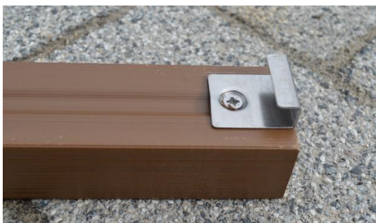
Mocowanie klipsa startowego AKS-1 do legara
